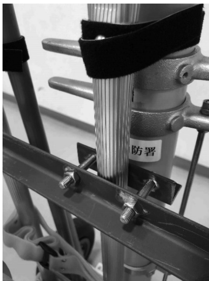
【写真7】台車にフレームを固定
