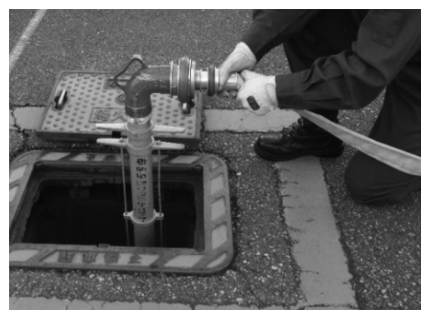
【写真 1 1】 スタンドパイプにホースを 結合
